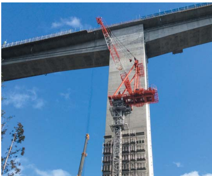
OTS-120N (橋脚工事)
