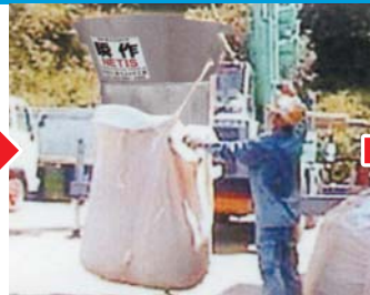
瞬作を移動して降ろし、瞬作からフレコンバッグを取り外す
