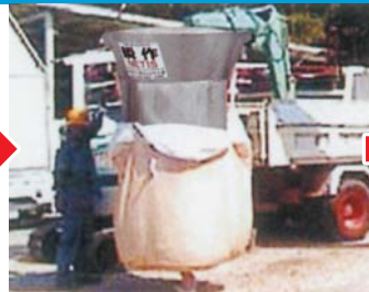
瞬作に土砂をバケツで入れ、吊り上げて移動する
