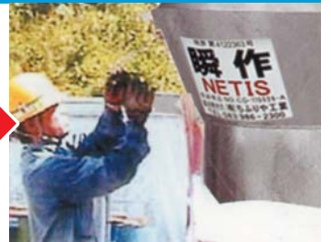
瞬作の楽に外せる治具でフレコンバッグを外し吊り上げて行程完了
