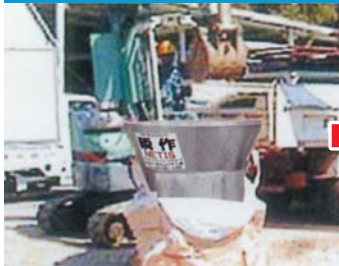
瞬作を吊り上げフレコンバッグを取り付け降ろす
